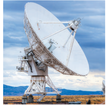
Рис. 21.3. Випромінювання вузького напрямленого пучка ультракоротких радіохвиль і приймання відбитого сигналу забезпечує параболічна антена радіолокатора
