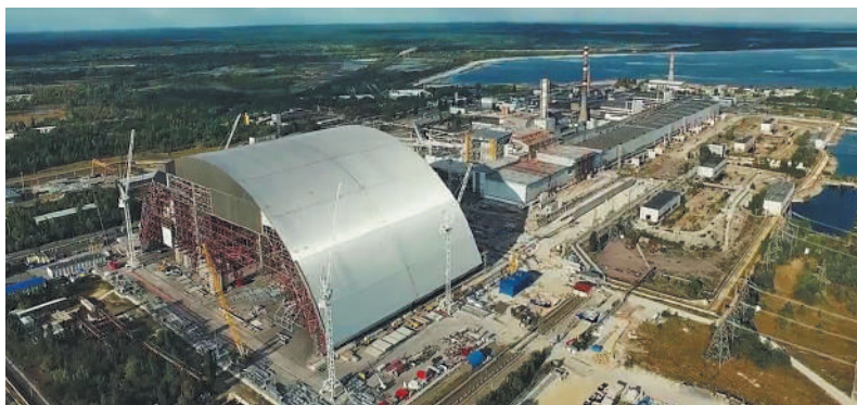
Рис. 27.8. Саркофаг над 4-м енергоблоком Чорнобильської АЕС
